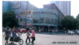
京华大院10栋改造后的新面貌
